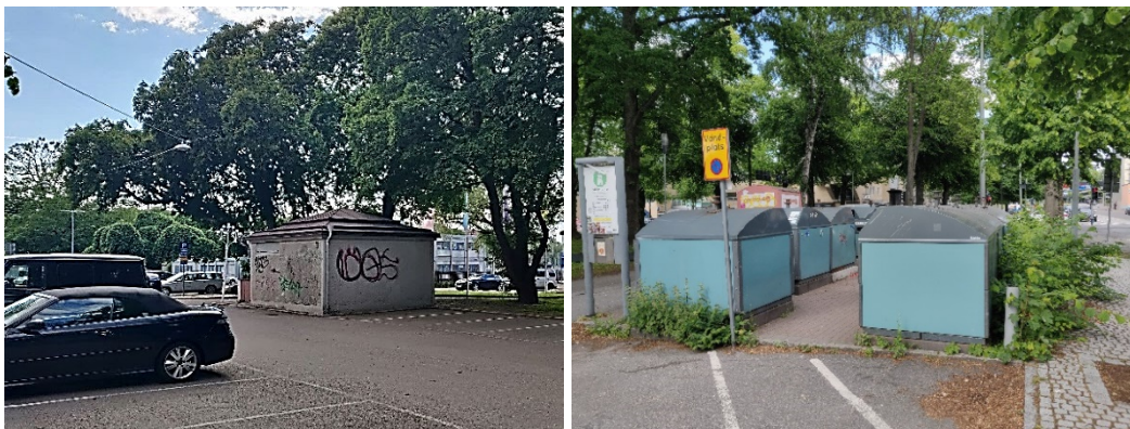
Befintlig transformatorstation bild till vänster, befintlig återvinningsstation bild till höger.
